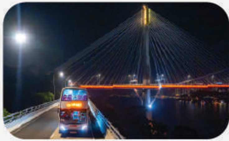
汀九橋 汀九桥 Ting Kau Bridge
